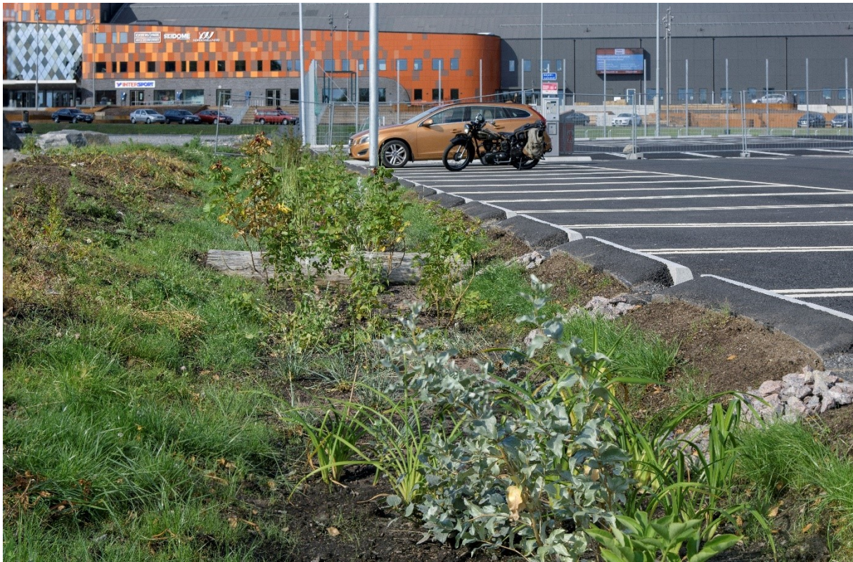
Figur 9 Regnbädd vid Kvibergs arena. Liknande lösningar skulle kunna användas i anslutning till parkeringsplatser, utmed vägar eller andra hårt belastade ytor. Foto: Peter Svensson
